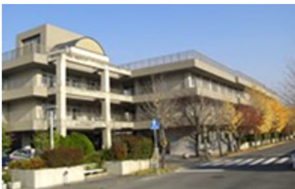
自立生活訓練センター(兵庫県神戸市)
